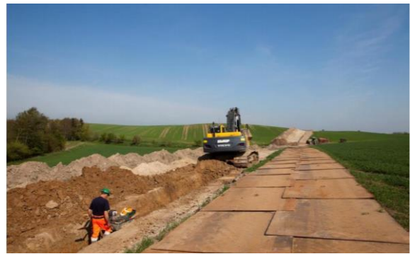
Figur 3.3: Eksempel på arbejdsbælte langs kabelanlæg med afrømmet rå- og muldjord samt køreplader. På billedet ses et kabeltracé med ét kabelanlæg. (Fotografi fra den publicerede Landsaftale for el- og fiberanlæg på landbrugsjord 2019 mellem landbruget og Dansk Energi).
