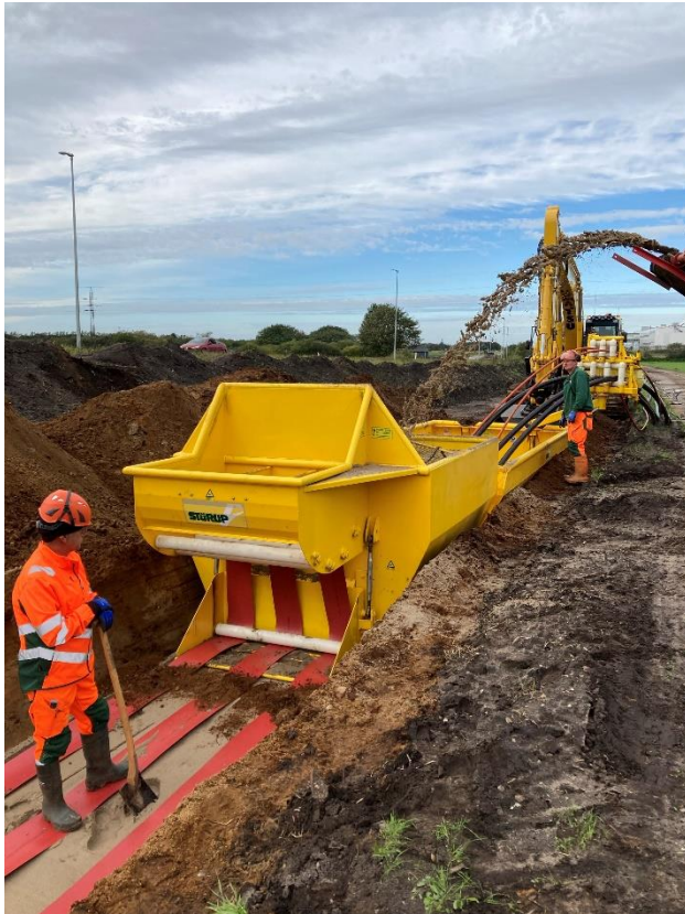
Figur 3.5: Eksempel på brug af gravekasse.
